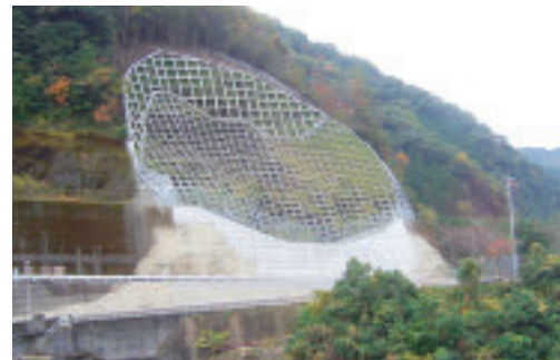
（復旧工事完了時）
